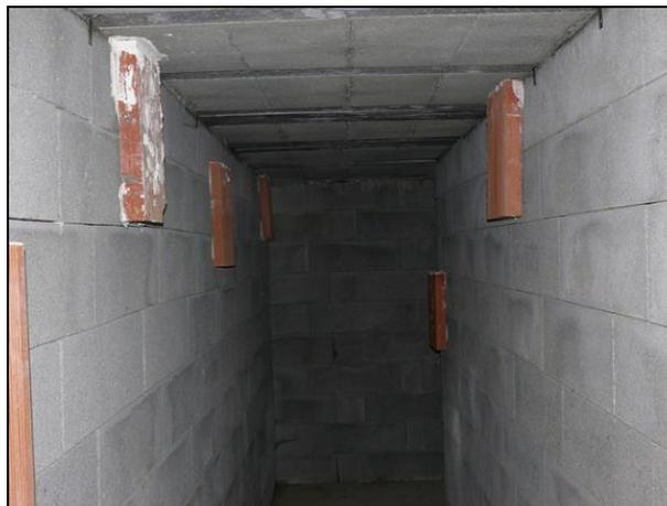
Tunnel avant d'être enfoui sous le remblais de terre (à gauche) et briques plâtrières installées dans le tunnel (Source : <http://gmb.bzh/actualite/souterrain-artificiel-tregueux/>)
